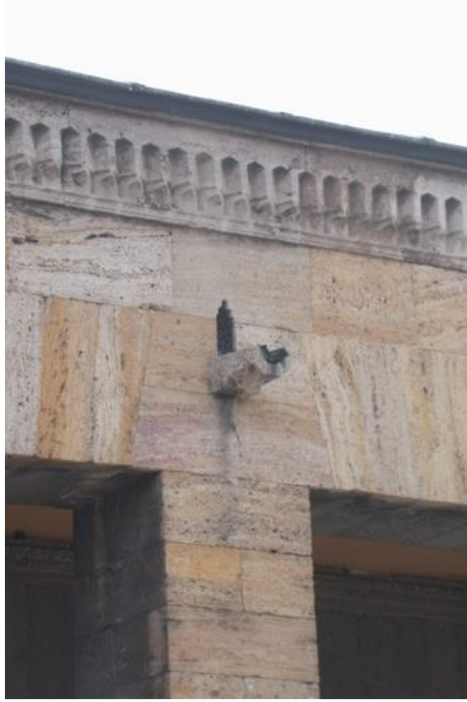
Şekil 5.56 Cepheden mukarnas ve Osmanlı çörteni detayı.
